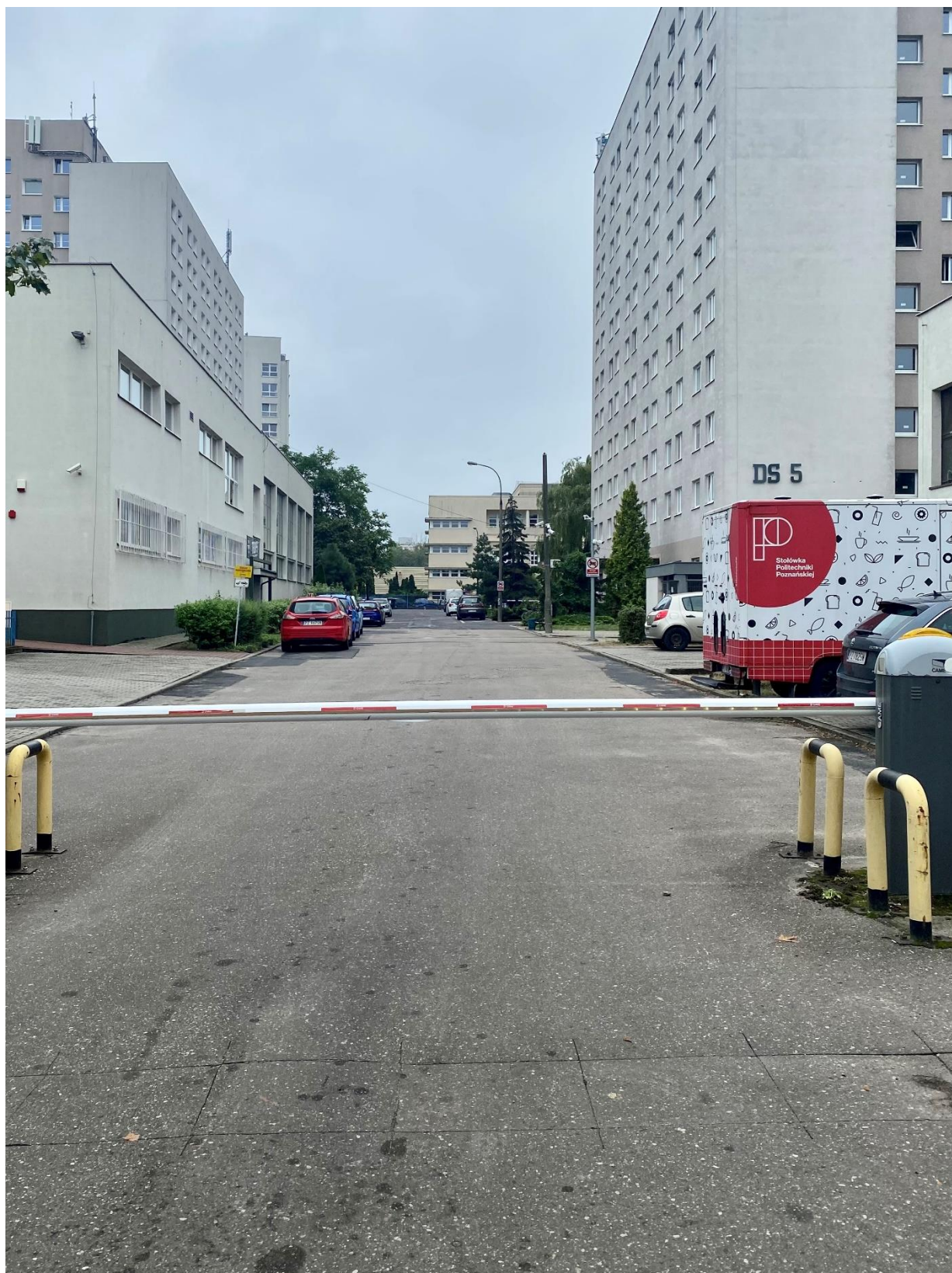
Zdjęcie Szlaban wjazdowy zlokalizowany na drodze pożarowej od ulicy Świętego Rocha
