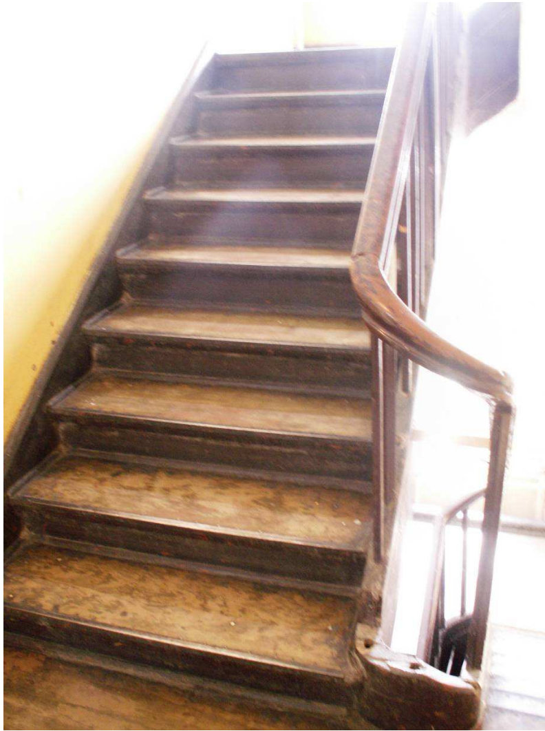
Rysunek 12. Budynek Domu Studenta stan istniejący
