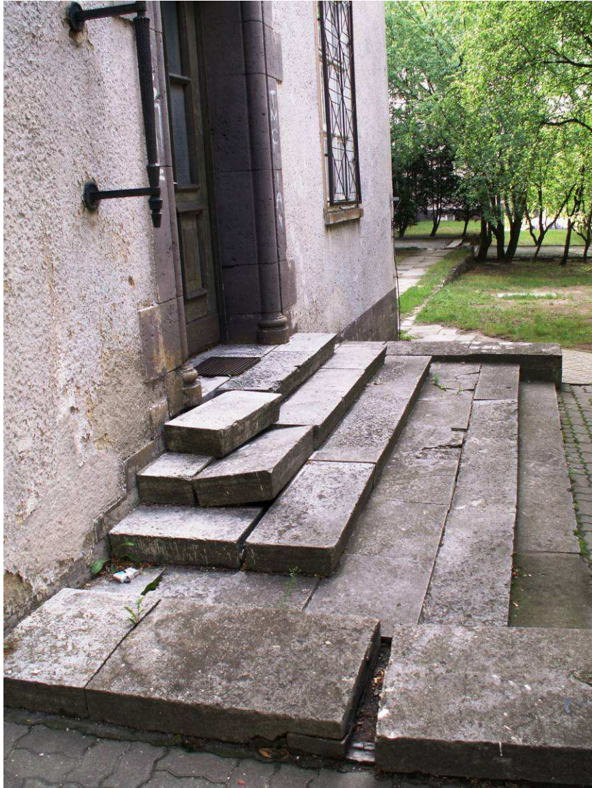
Rysunek 5. Wejście do budynku stan istniejący
