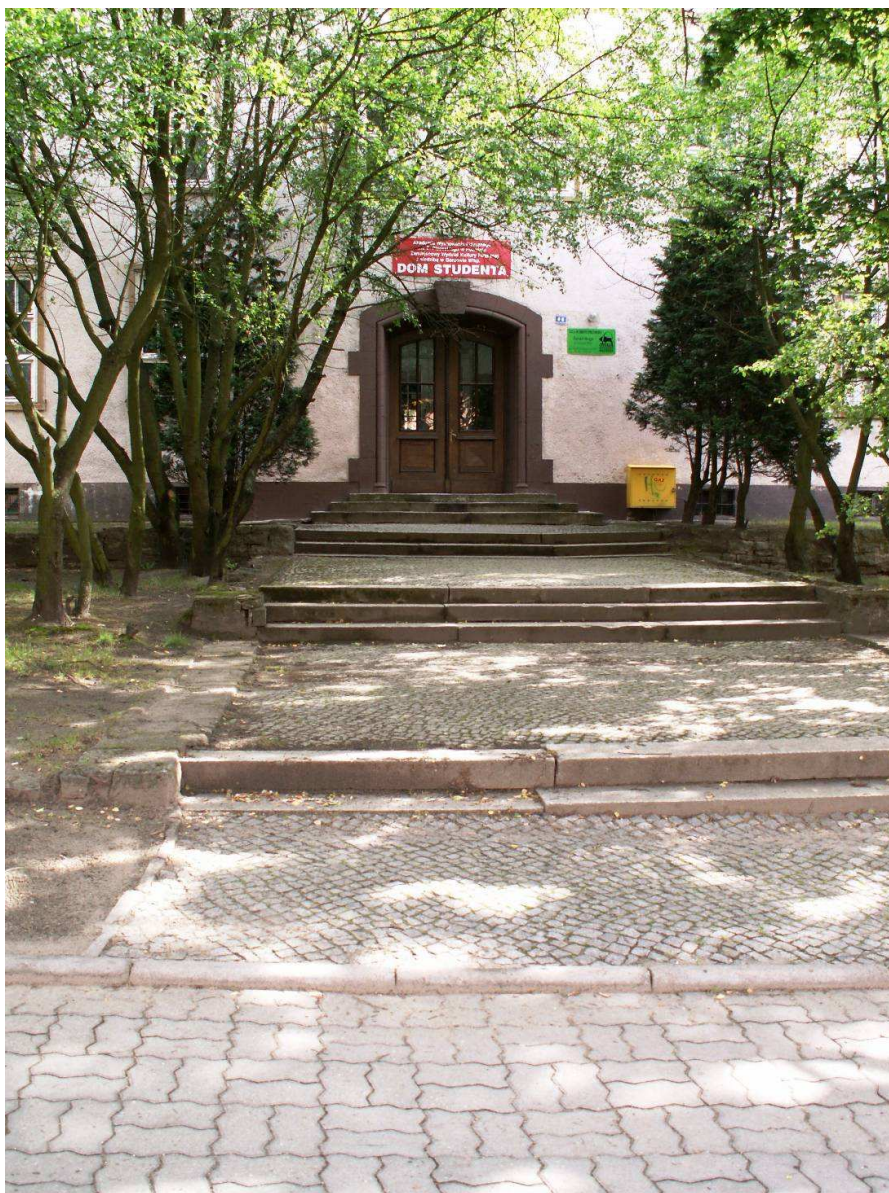
Rysunek 2. Budynek Domu Studenta stan istniejący
