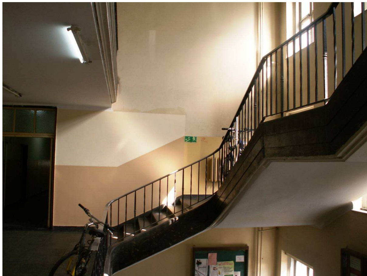
Rysunek 3. Wnętrze planowanego do modernizacji budynku stan istniejący
