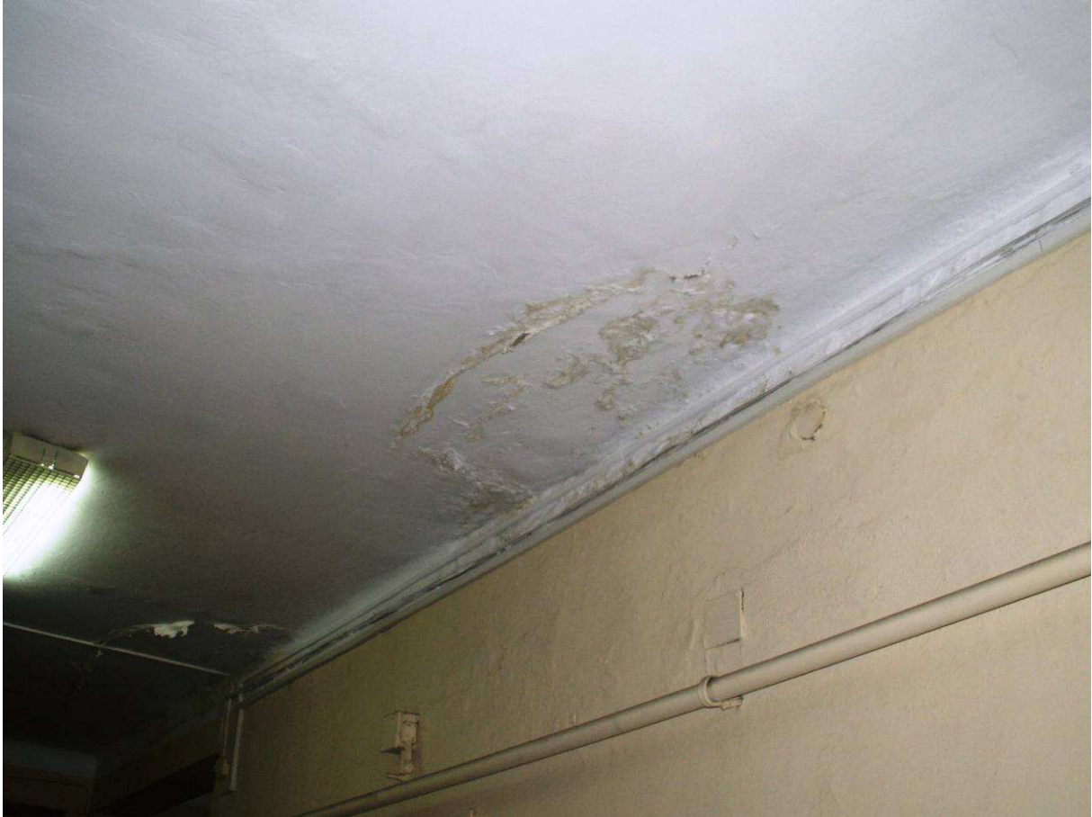
Rysunek 11. Budynek Domu Studenta stan istniejący
