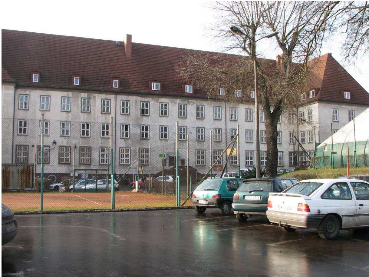
Rysunek 1. Budynek Domu Studenta stan istniejący
