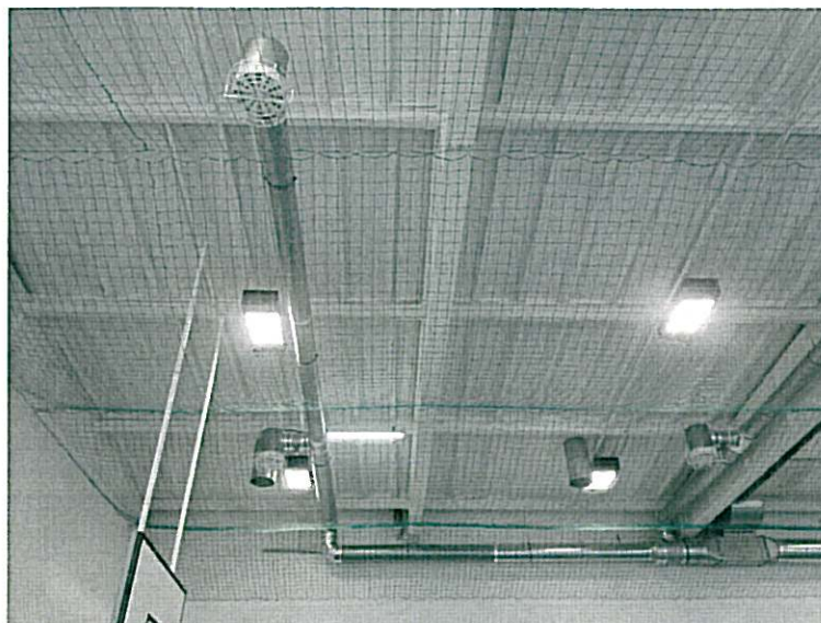
Fot. 2 Widok na strop z kanałami wentylacyjnymi.
