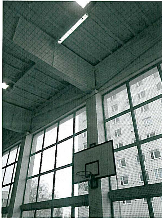
Fot. 4 Dźwigar stalowy – oparcie na słupie.
