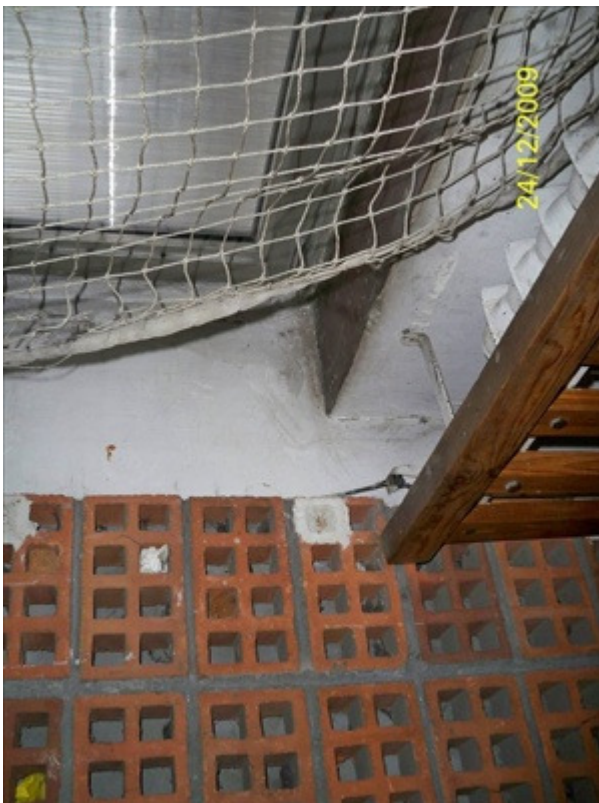
POM. 0-2: SALA GIMNASTYCZNA
