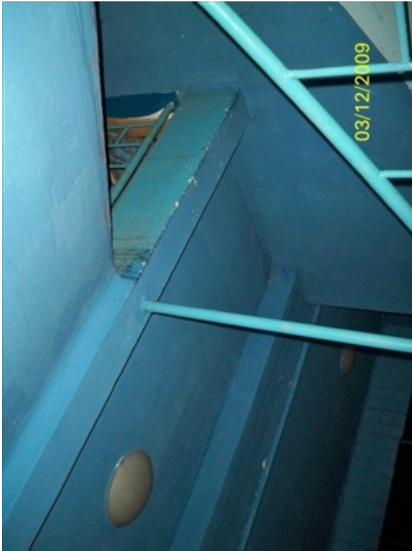
POM. 0-31÷33: KLATKA SCHOD. / KORYTARZ
