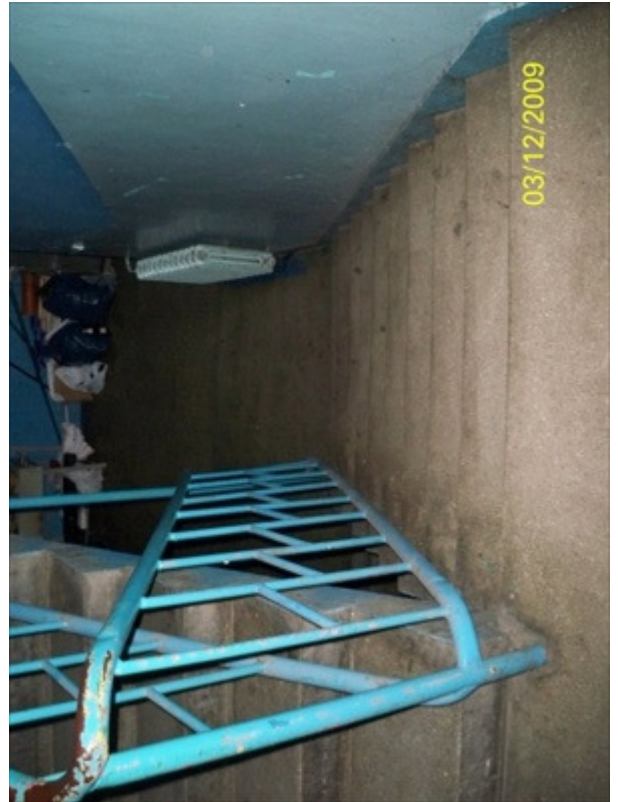
POM. 0-31÷33: KLATKA SCHOD. / KORYTARZ
