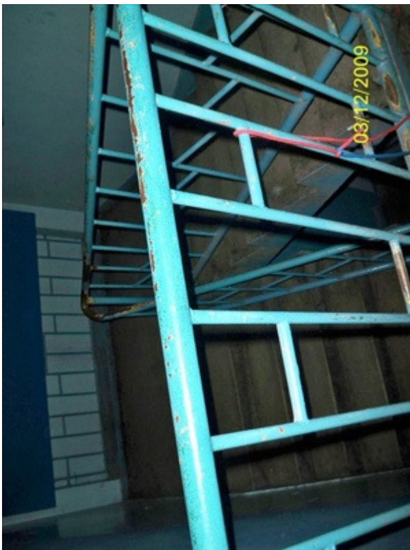
POM. 0-31÷33: KLATKA SCHOD. / KORYTARZ
