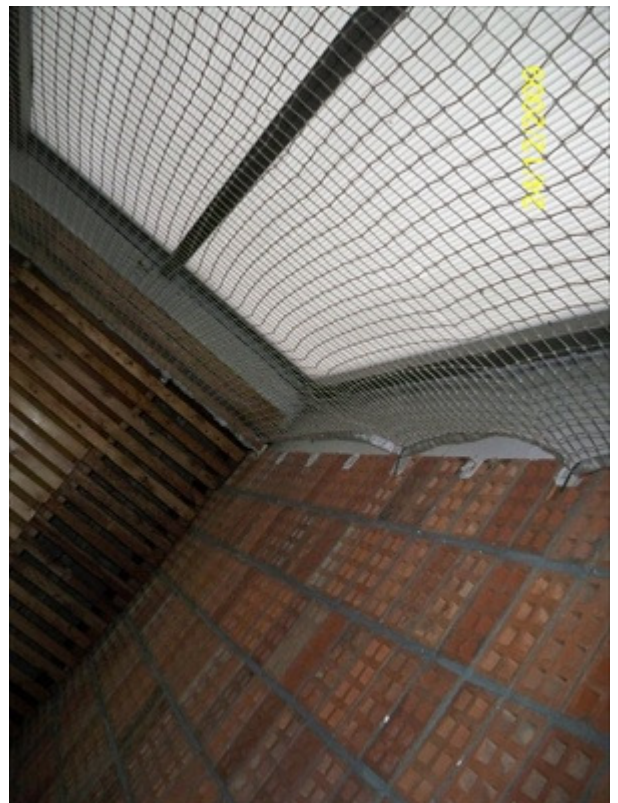
POM. 0-2: SALA GIMNASTYCZNA
