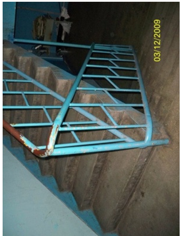
POM. 0-31÷33: KLATKA SCHOD. / KORYTARZ
