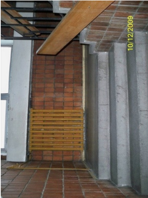
POM. 0-41/42: KLATKA SCHODOWA
