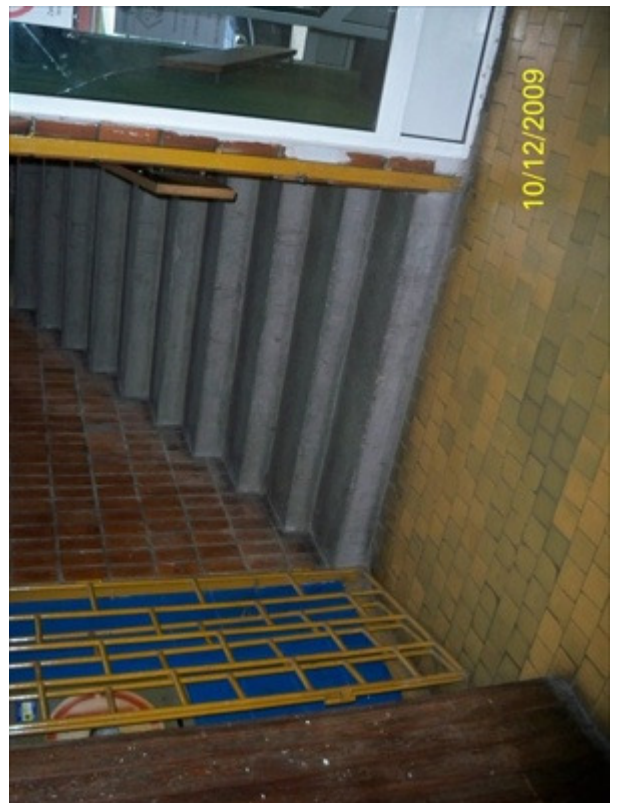
POM. 0-41/42: KLATKA SCHODOWA
