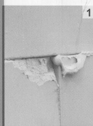
1 wyrównanie podłoża - wypełnienie mniejszych ubytków zaprawą cienkowarstwową
