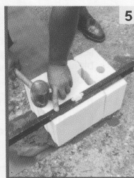
3 użycie młotka gumowego i poziomicy ułatwia precyzyjne ustawienie elementu murowego
